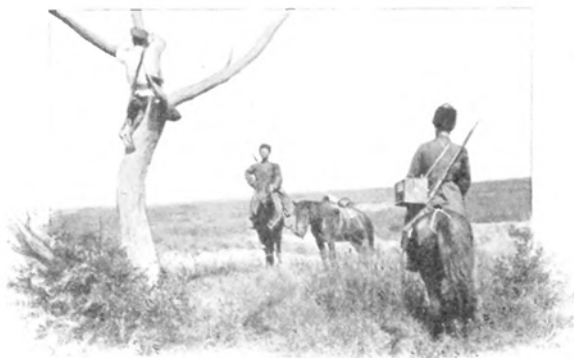
Проводка телефона.
